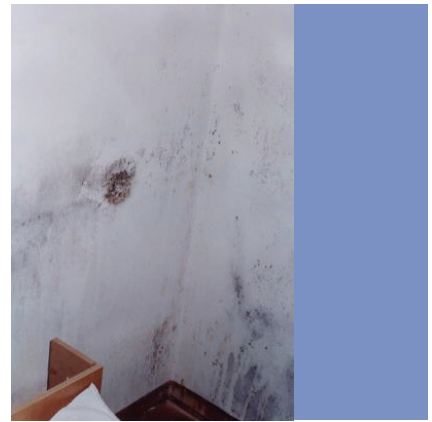
Punkt förmige und Flächenwärmebrücken
